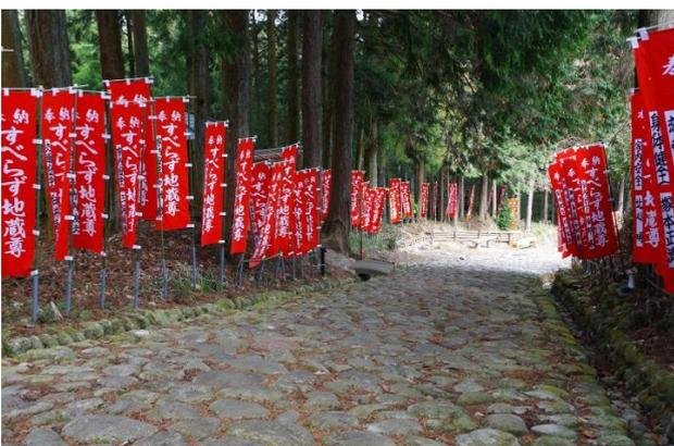
江戸時代、金谷坂は急坂なうえに「あおねば」と呼ばれる粘土層が露出しており、雨が降るとぬかるみ、大名行列や旅人は大変苦勞しました。そこで江戸時代末期、約 400 間 (約 720m) の石畳が「山石」を敷き詰めて造成されました。この時使われた山石は、牧之原台地の耕作土の下に厚く堆積している「牧之原礫層」に含まれている大井川の河原石と同じ丸石で、現在の大井川の河原石よりもザラついて滑りにくいものです。明治以降、電話線や電線等の敷設により掘り起こされ、その後舗装されたため、もとの面影は失われていました。
